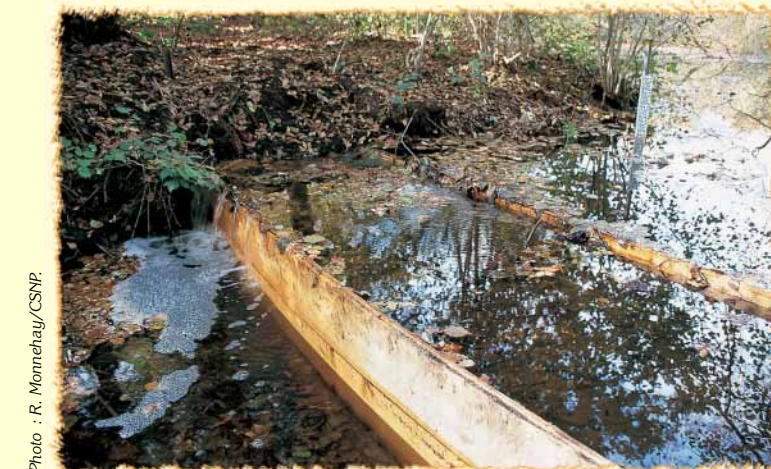
Les seuils retiennent l'eau sur le site pour répondre à un déficit constaté ces dernières années.
