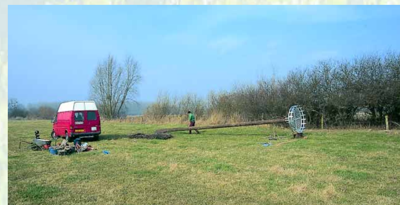
Pose de la plate-forme à cigogne.
